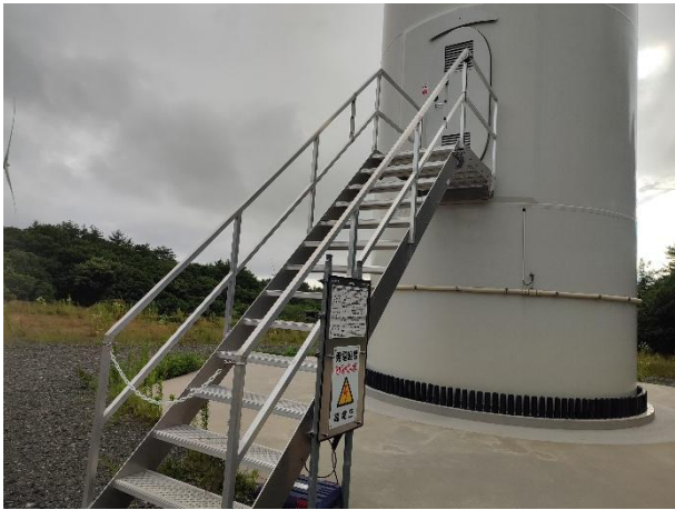
写真 2-1 調査機器設置状況
