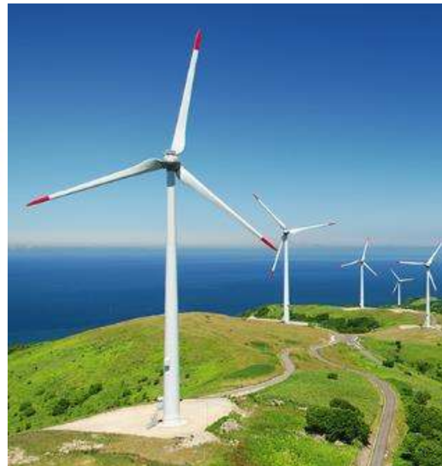
尻別風力発電所 (寿都町・蘭越町)
